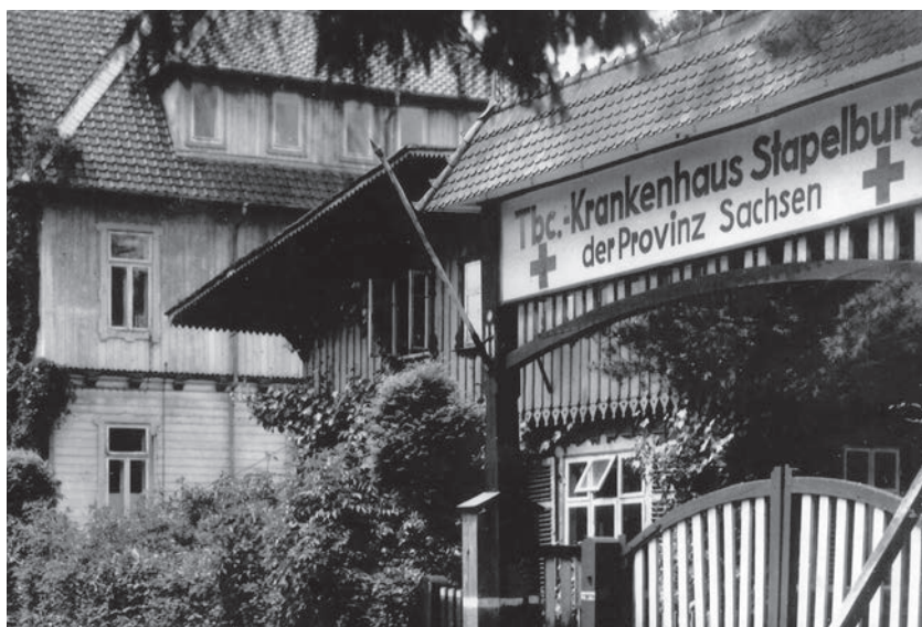
Abb. 4 Eingangstor Tbc-Krankenhaus Stapelburg (o. Dat.).
